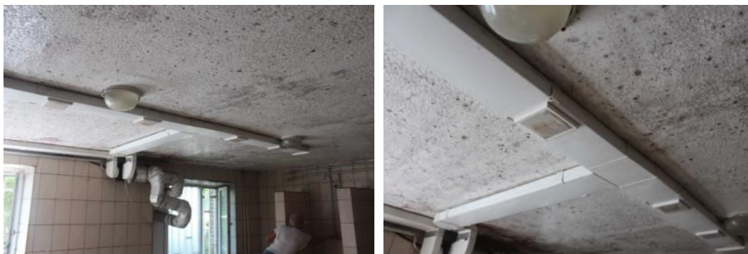
Мал. 8 – Компоненти системи вентиляції
