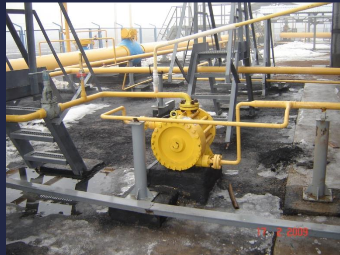
ТДА на базі струминно-реактивної турбіни потужністю 100 кВт на "ГРС-1 Суми"
