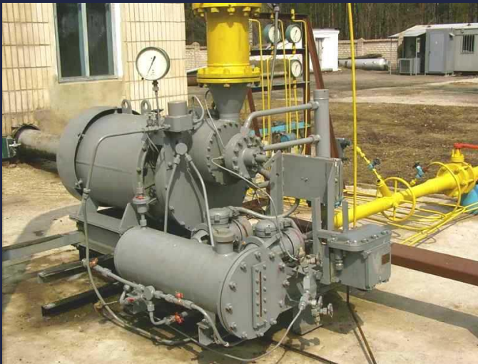
ТДА на базі струминно-реактивної турбіни потужністю 100 кВт на "ГРС-1 Суми"
